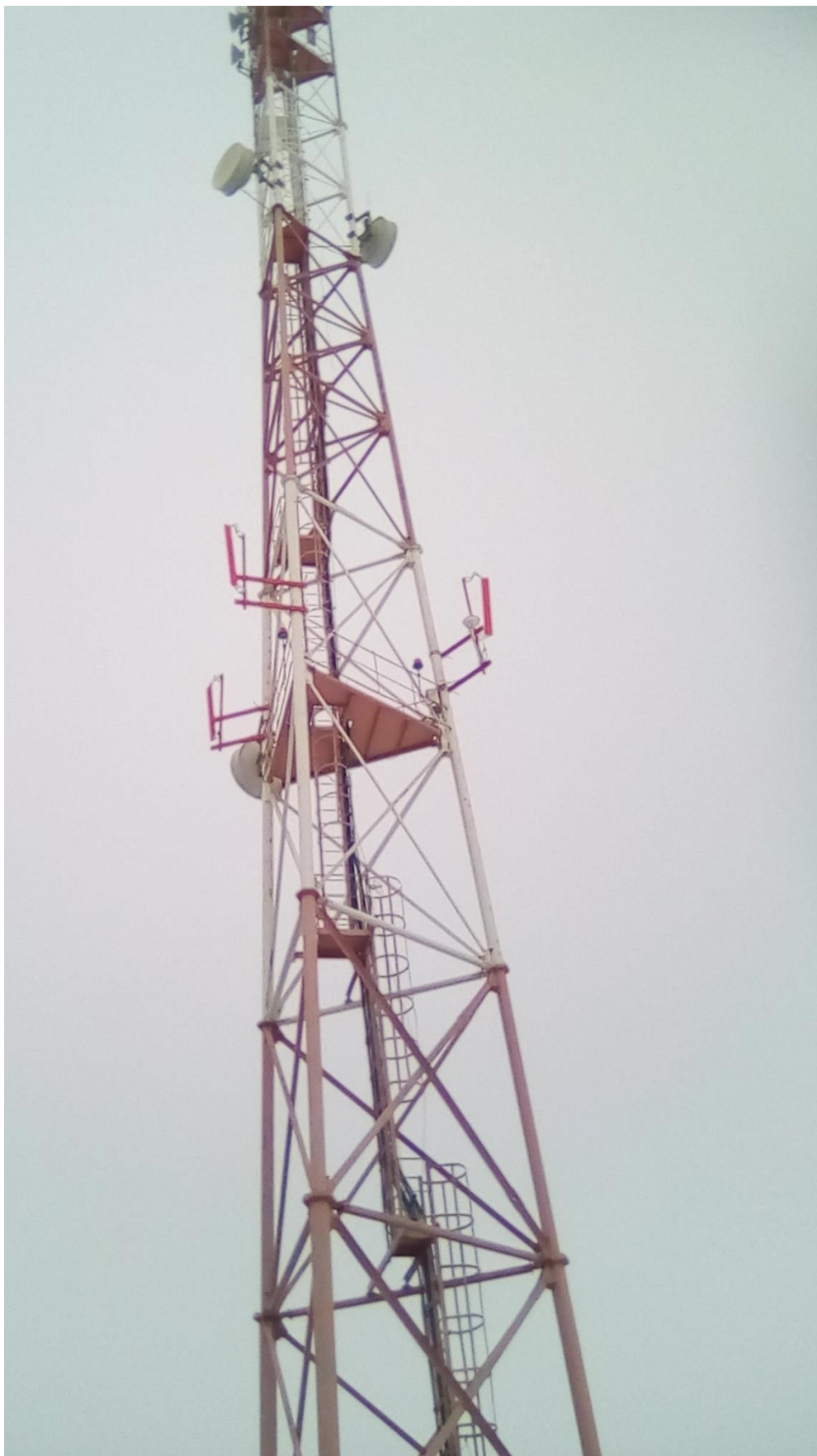
Рисунок 65 - Приёмники АЗН-В 1090 ES на мачте сотовой связи
